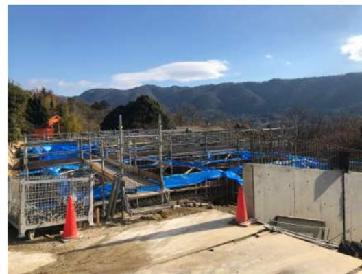
東館工事現場では、地上一階部分が顔を出しました。斜面に建てられているため、「地上1階・地下1階」となります。地下1階部分には、駐車スペースもできますよ。
